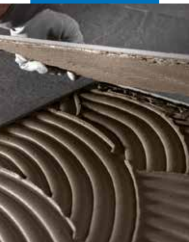
Укладка на пол тонкого керамогранита
